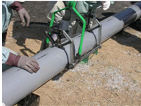
※スライド管挿入時は、挿入部分全面に多めに滑剤を塗布すること。
