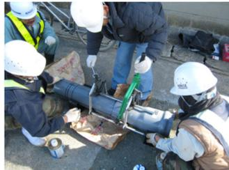
曲管の組立: 曲管の組立は仮組立を行い、接続方向を確認しマーキングしておく、失敗を防ぐことができます。
