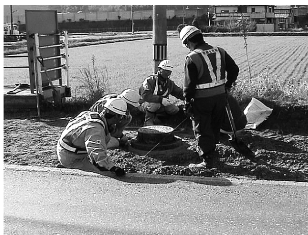
⑥防護ふた設置・完了
