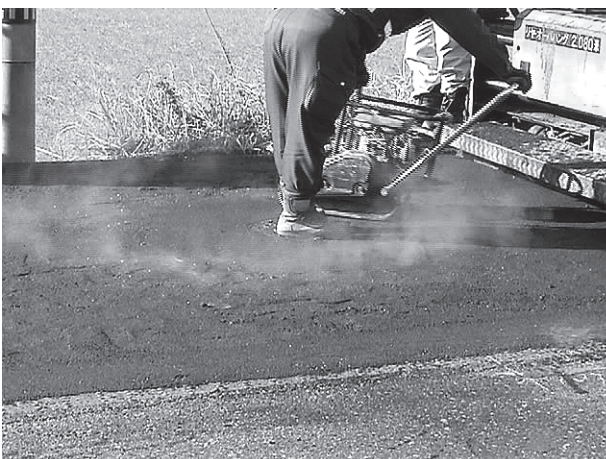
⑮振動コンパクターでの転圧
