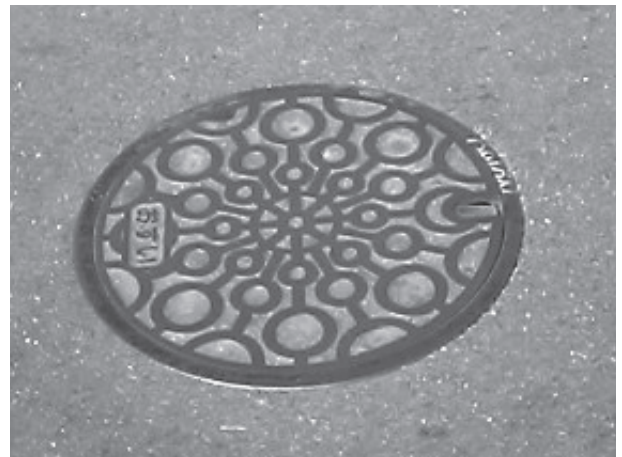
⑳防護ふた周辺状況
