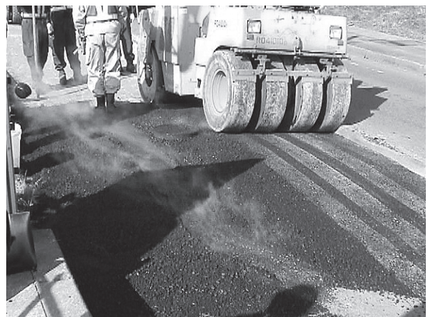
⑪ 転圧状況
