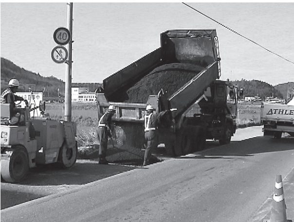
⑧ アスコン投入
