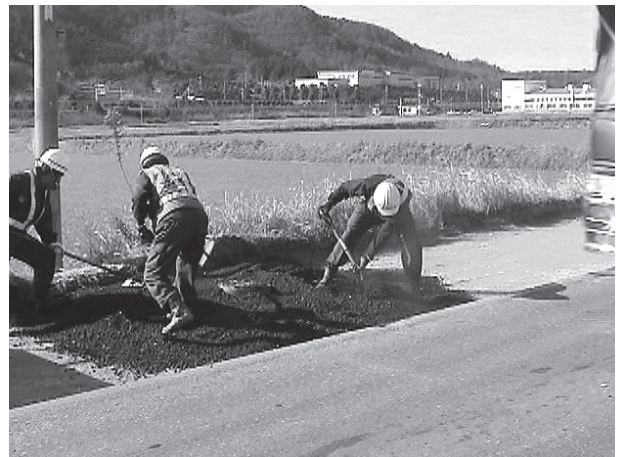
⑨ アスコン敷きならし
