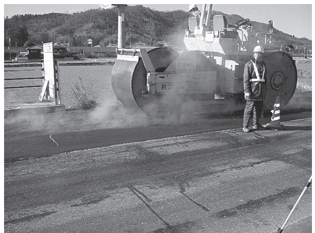
⑯マカダムローラでの転圧
