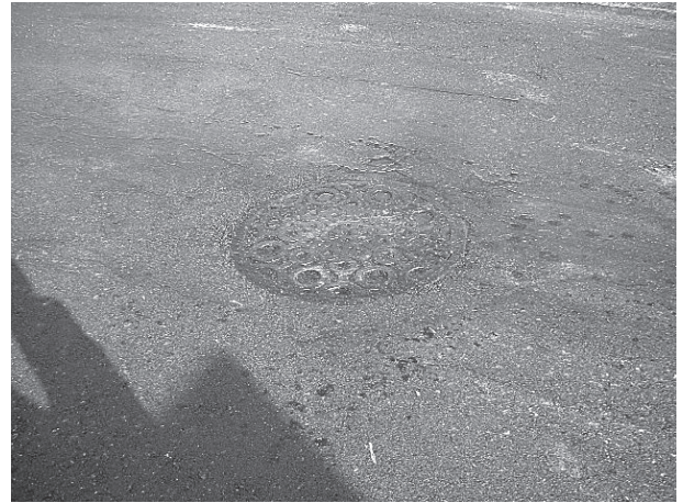
⑱二層目舗装終了時
