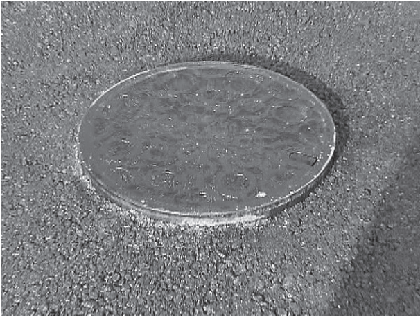
⑫第一層転圧終了時
