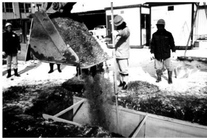
写6-1 砕石落下試験
