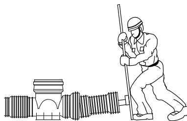
図7-31 リブパイプの挿入
